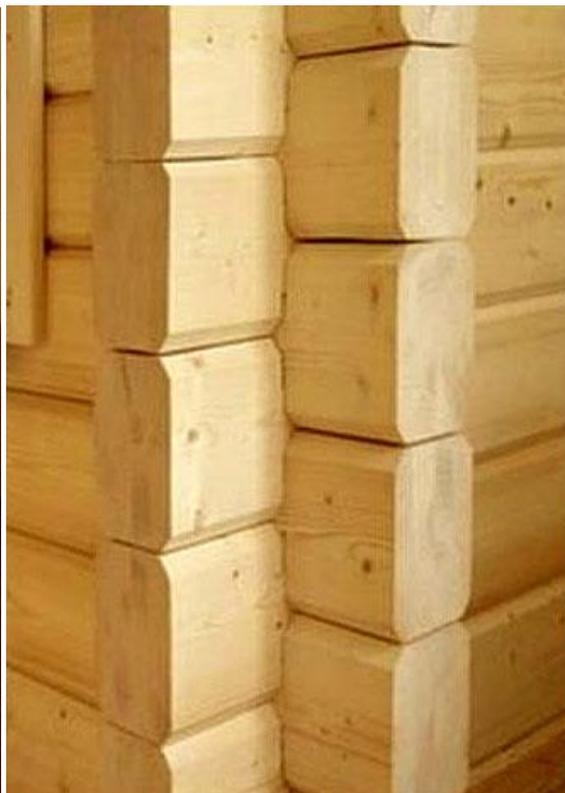
Как правило, после осадки сруба, построенного из профилированного бруса, конопатка утеплителем не требуется. Кроме того, профиль бруса построен таким образом, что при дожде вода не попадает между венцами, что защищает конструкцию от гниения. Ну и конечно, дом из профилированного бруса будет иметь привлекательный внешний вид сразу после постройки и зачастую не требует дополнительной отделки.
